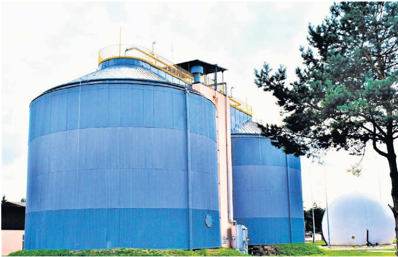
Wodociągi Chrzanowskie. Komory fermentacyjne i zbiornik na biogaz
