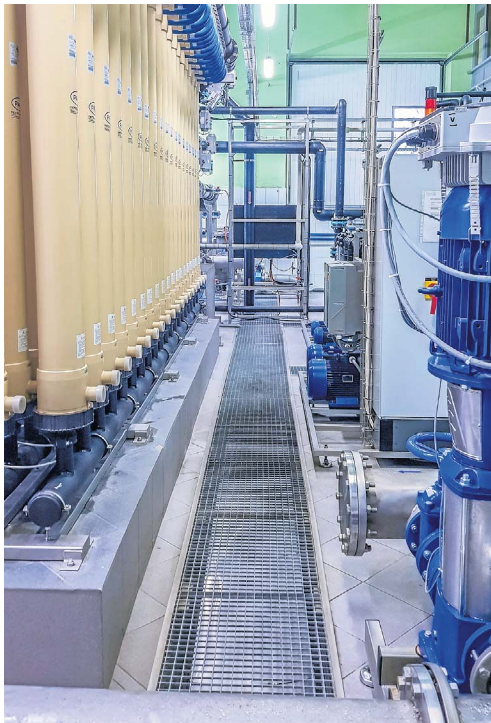
System ultrafiltracji wody w Zakładzie Wodociągów i Kanalizacji w Andrychowie
