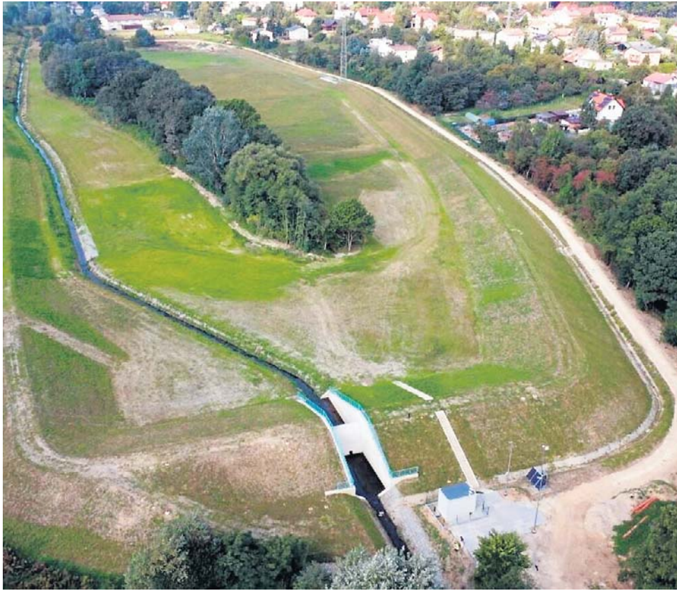
Suchy zbiornik Malinówka 1 to jedna z form ochrony przeciwpowodziowej
