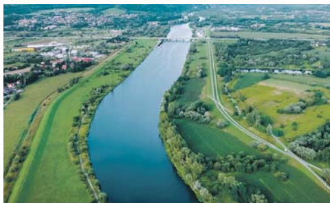
Wały przeciwpowodziowe - okolice Tyńca
