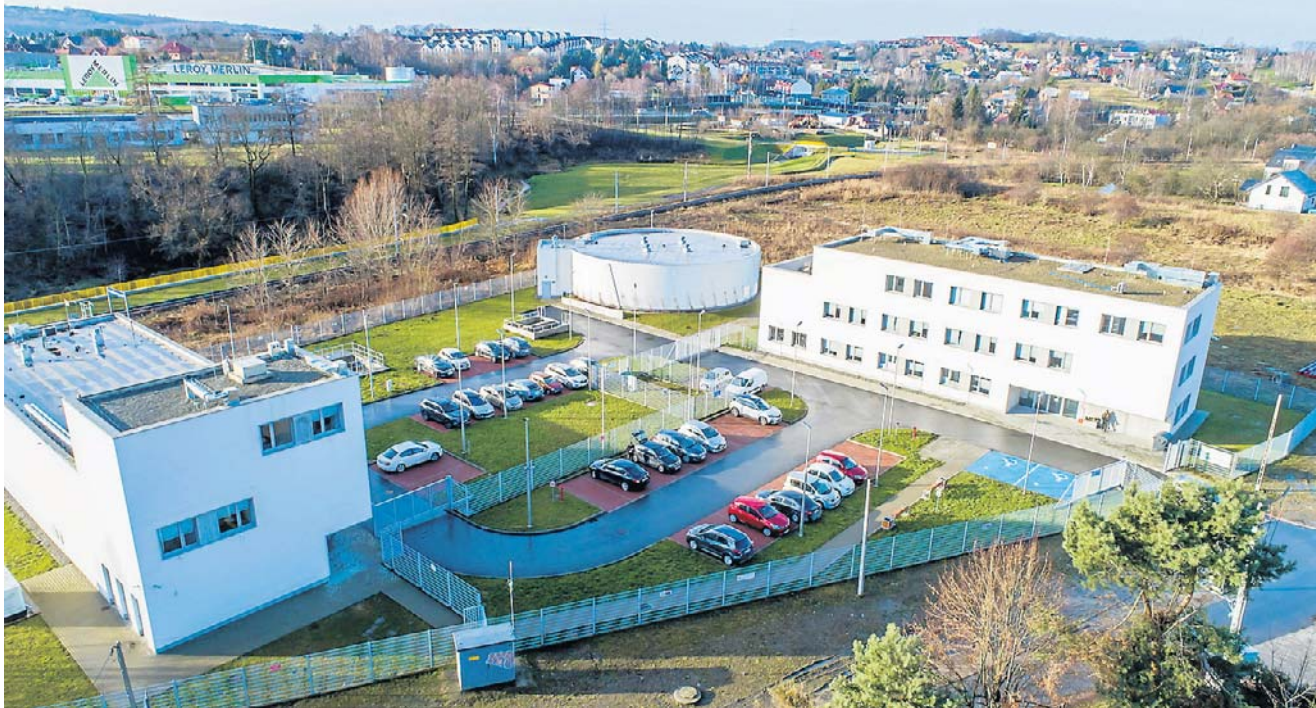
Stacja uzdatniania wody w Wieliczce Bogucicach
